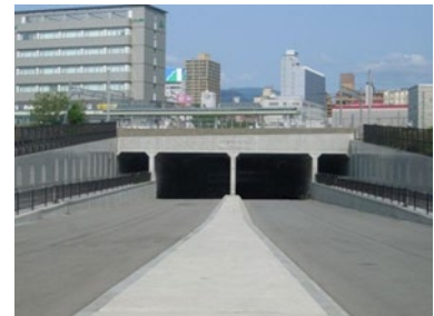
奥羽本線山形駅構内 双葉町Bv新設
