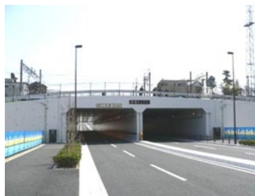
成田線成田駅構内 不動ヶ岡Bv新設
