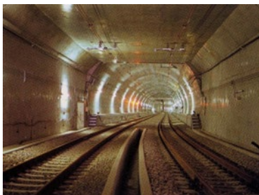
東京臨海高速鉄道りんかい線 第2 広町トンネル新設
