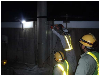
内部充填モルタル施工
