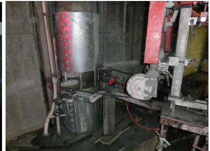
PC 鋼線切断
