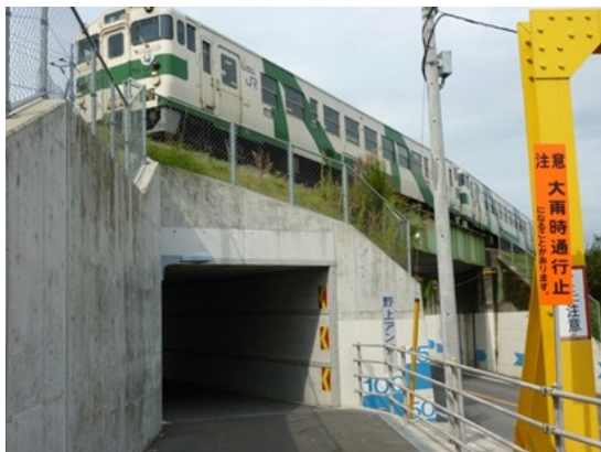
烏山線 滝・烏山間 人道橋(歩道) (栃木県那須烏山市)
