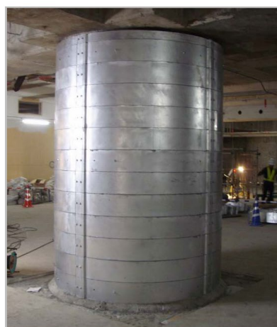
溶融亜鉛めっき処理仕様による施工事例（左：矩形断面、右：円形断面）
