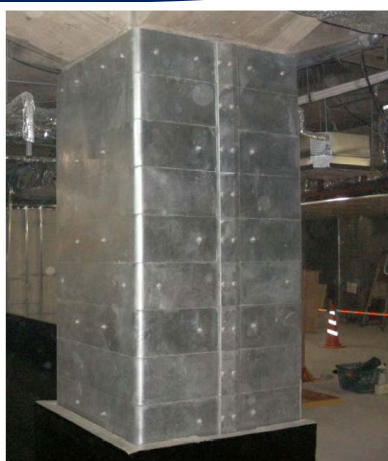
溶融亜鉛めっき処理仕様による施工事例（左：矩形断面、右：円形断面）
