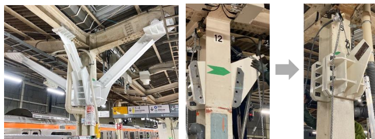
武蔵野線西船橋駅 (3方向へ補強)
