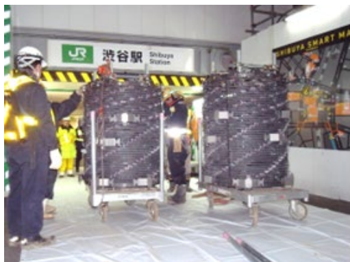
鉄筋かご場内運搬（人力での運搬が可能）
