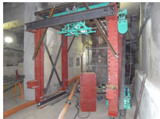
建込みフレーム組立て
