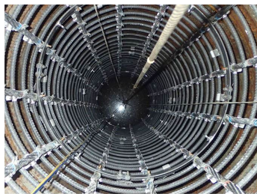
鉄筋かご伸展状況
