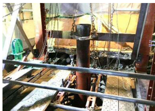
トレミー管建込み
