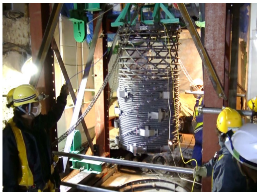
鉄筋かご伸展（建込み）※作業空間 3.2m
