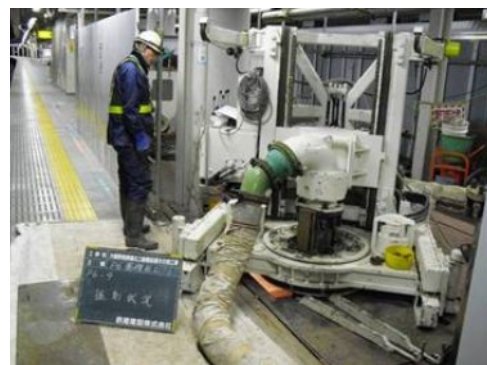
ホーム上での掘削状況
