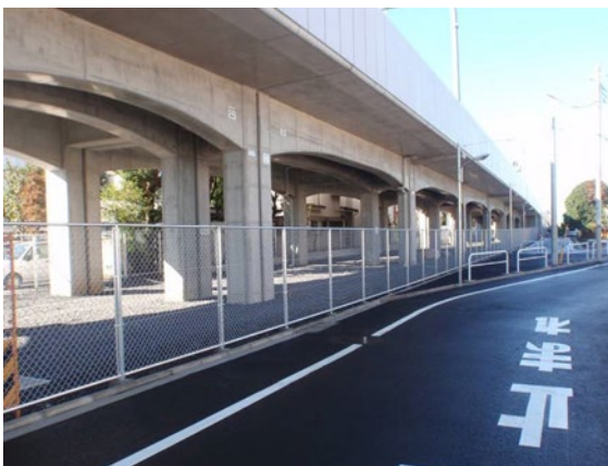
中央線三鷹立川間高架橋
