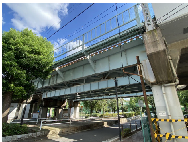
三田線西台第二架道橋 （撮影：JR東日本コンサルタンツ(株)）
